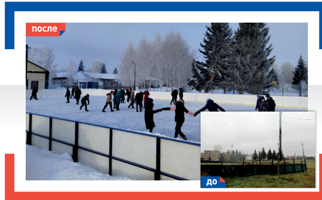
2021 Обустройство хоккейной коробки – 1 194 тыс. рублей
